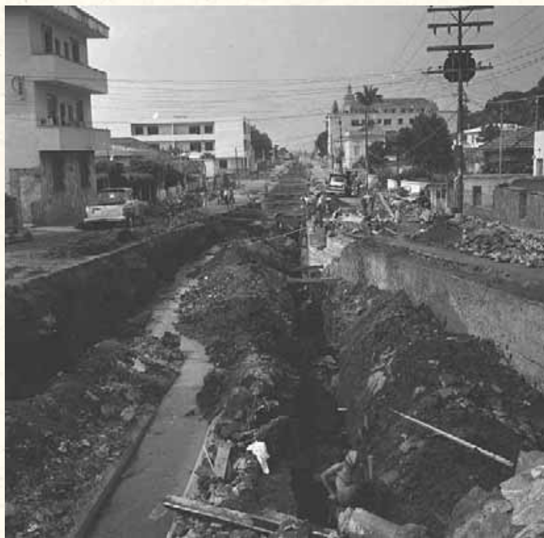
Imagem 11. Canalização do Acaba Mundo, Rua Professor Moraes. 05/1963. Fundo: ASCOM/ Arquivo Público da Cidade de Belo Horizonte.
