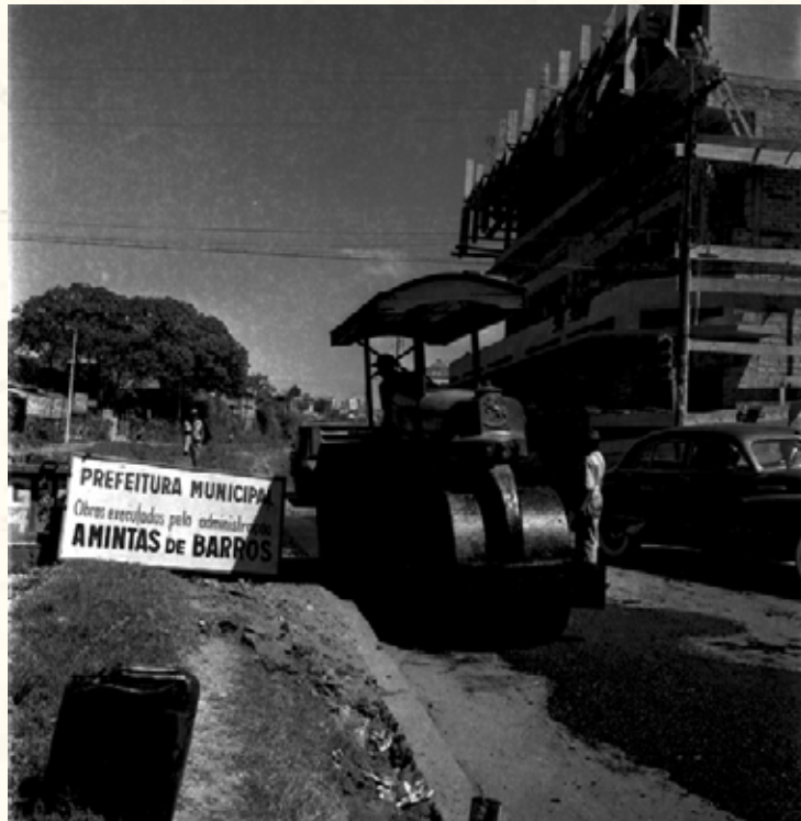
Imagem 07. Recomposição do asfalto da Avenida Pedro II. 04/1961. Fundo ASCOM/ Arquivo Público da Cidade de Belo Horizonte.
