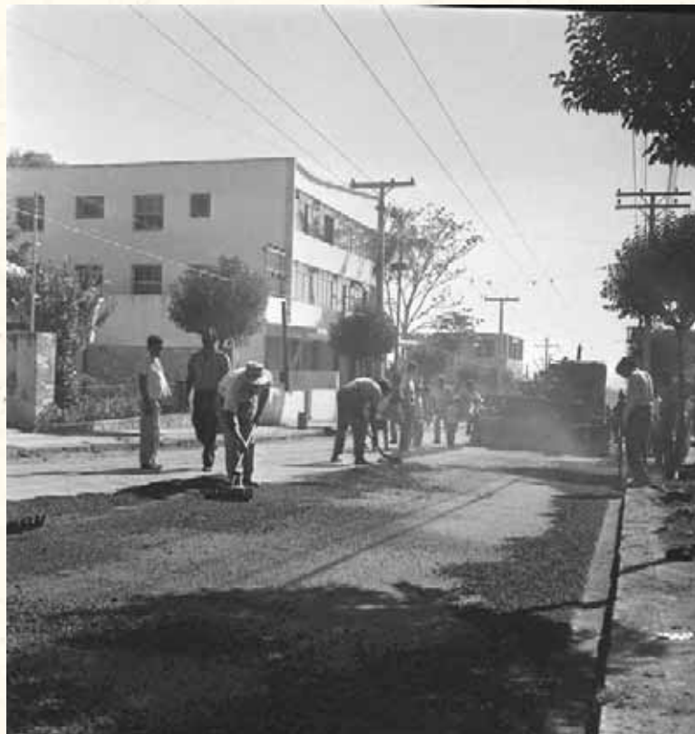
Imagem 08. Asfaltamento na Rua Grão Mogol – 25/06/1960. Fundo ASCOM/ Arquivo Público da Cidade de Belo Horizonte.
