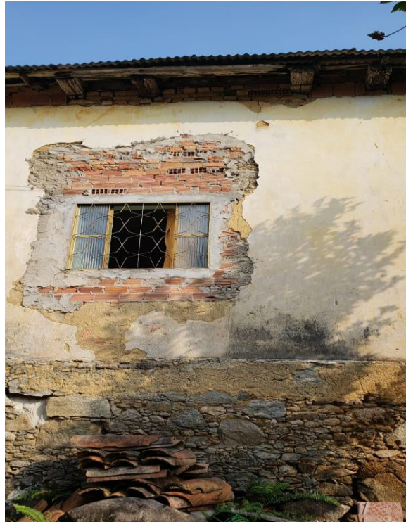
Figura 10. Estrutura de uma das casas da Fazenda Mandioca utilizada como base para construção recente (detalhe para telhas do mesmo período da fundação).
