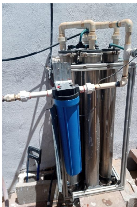
Figura 3. Unidad de desalinización por ósmosis inversa de baja presión y sistema fotovoltaico instalados en Samalayuca, Chihuahua.
